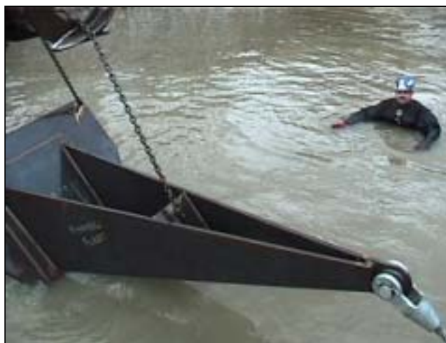
Figure 3: Installation of «Stevin» Anchor.
