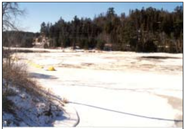
Figure 11 : L'accumulation de la glace morcelée à l'amont de l'estacade près de 24 heures avant l'événement. Photo prise le 13 mars 2000.
