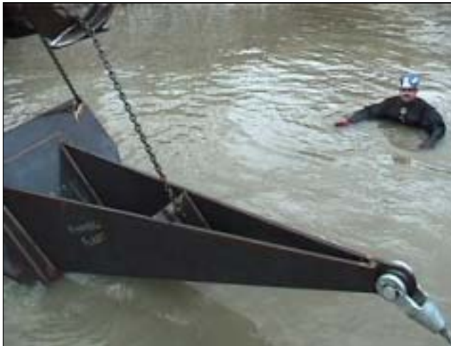
Figure 8 : Installation de l'ancre «Stevin ».
